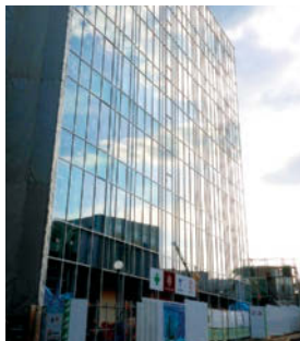
新築の教育実習棟。臨床能力を高めるための、スキルスラボやトレーニングセンターなどを設備
